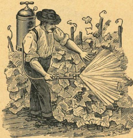
Eine selbsttätige Spritze mit zwei eingebauten Pumpen zum Einpumpen der Flüssigkeit. Die Spritze arbeitet mit sechs Atmosphären Druck und verteilt selbst beim längsten Bambusrohr die Flüssigkeiten nebelartig auf die Bäume. Mit dieser Spritze kann eine Person ohne weitere Hilfskraft schnell und gewissenhaft arbeiten. Gebrauchsanweisung wird jeder Spritze beigegeben.
